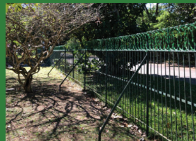
Instalação de concertinas na Rua Dulcídio Cardoso/parquinho entre os prédios Lucca e Didducio
