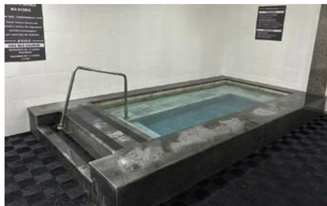
Reforma e limpeza da hidromassagem
